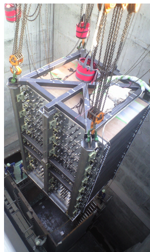
図8 ミューオンモニター設置時の様子 [7]
