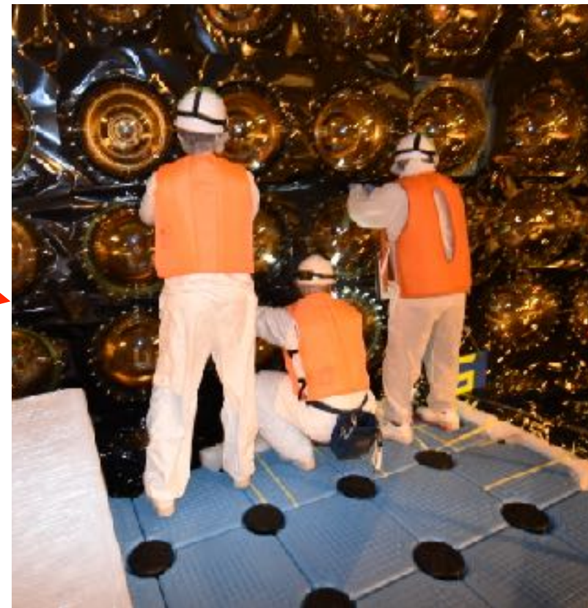
ID:浮床に乗って、PMTの交換
