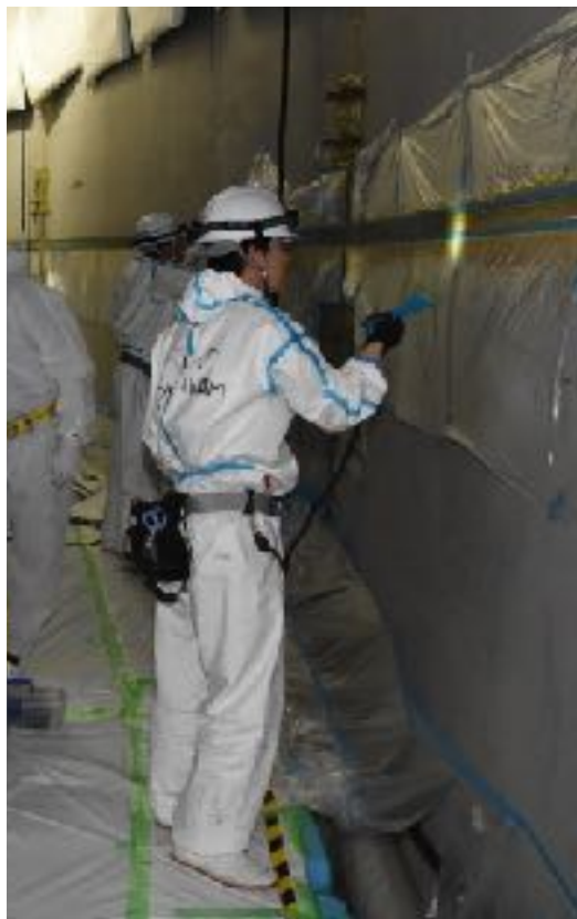
止水剤での溶接部を塞ぐ
